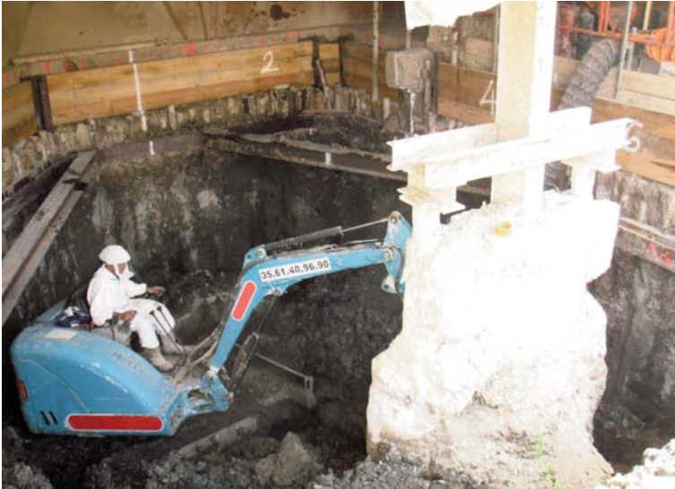
Microberlinoise sous bâtiment avec reprise en sous-œuvre
