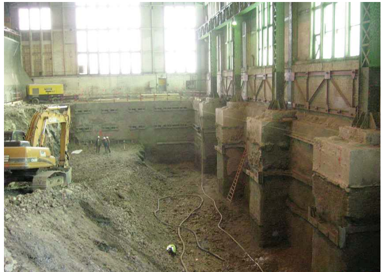
Microberlinoise sous bâtiment avec béton projeté et liernes
