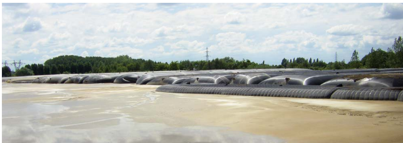
Traitement sur site en sacs filtrants
