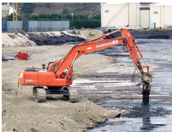
Traitement in-situ par inertage
