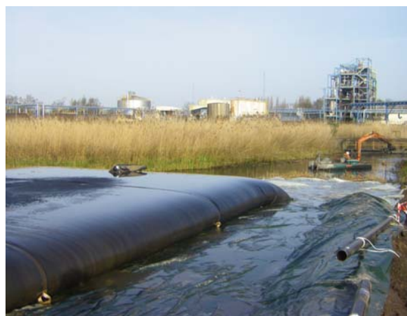
Traitement sur site d'une lagune
